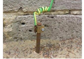
Quand une tension anormale ou "tension de défaut" est créée, l'écoulement via la prise de terre du courant de défaut associé permet le déclenchement des dispositifs de protection.
